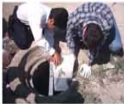
Instalación de dosificadores en la alcantarilla
